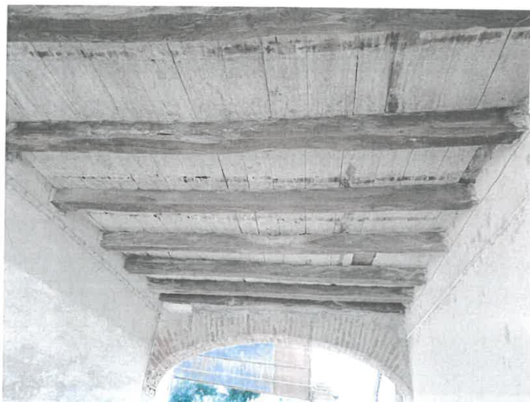
FOTO 4 - VISTA SOLAIO IN LEGNO SU ANDRONE CARRAIO
