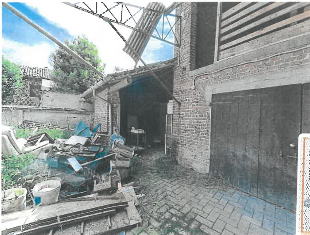
FOTO 15 - VISTA DEL RIPOSTIGLIO PRESSO L'ANGOLO DI SUD-EST
