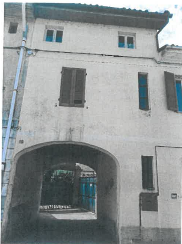
FOTO 3 - VISTA ANDRONE DI ACCESSO CARRAIO DALLA VIA RUVA
