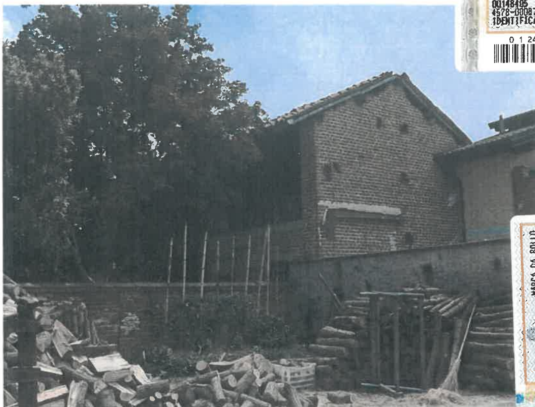
FOTO 19 – VISTA DALLA PROPRIETA' CONFINANTE DEL LATO DI NORD-OVEST DEL FABBRICATO RUSTICO
