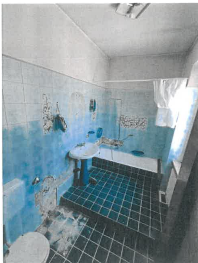
FOTO 40 – VISTA INTERNA LOCALE BAGNO UBICATO AL PIANO PRIMO
