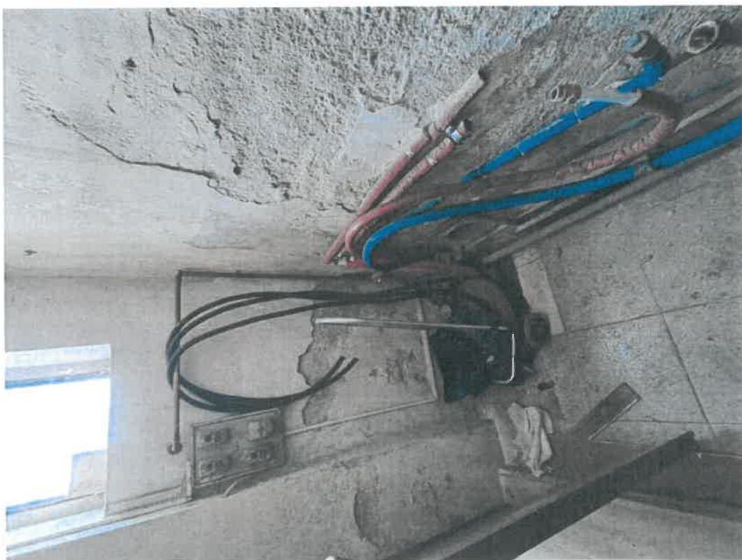
FOTO 31 / 32 – VISTE INTERNE DEL SOTTOSCALA UBICATO AL PIANO TERRENO CON RETI FUORITRACCIA DELL'IMPIANTO DI RISCALDAMENTO ESISTENTE
