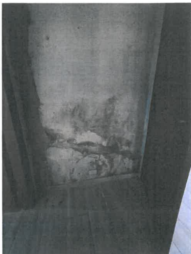
FOTO 29 – DISIMPEGNO NOTTE PIANO TERRA ( TRACCE DI UMIDITA' DI RISALITA)
