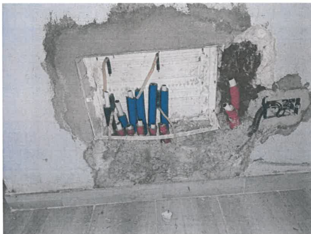
FOTO 30 – COLLETTORE IMPIANTO DI RISCALDAMENTO PRESSO CORRIDOIO DEL PIANO TERRA
