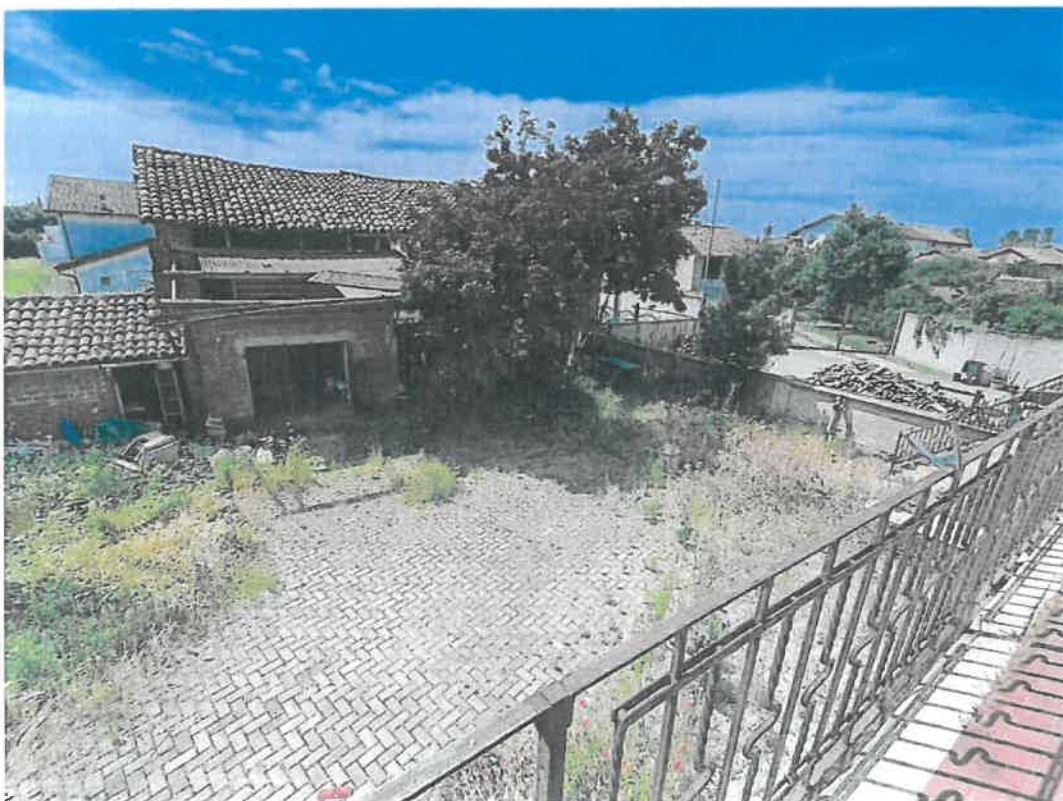
FOTO 12 – VISTA DELL'AREA DI CORTE INTERNA PRIVATA E DEL FABBRICATO RUSTICO
