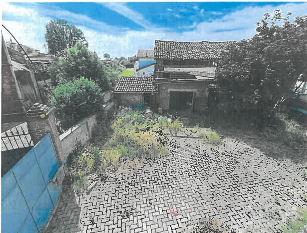
FOTO 11 – VISTA DELL'AREA DI CORTE INTERNA PRIVATA E DEL FABBRICATO RUSTICO
