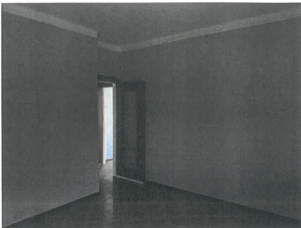
FOTO 39 – VISTA INTERNA LOCALE CAMERA UBICATO AL PIANO PRIMO
